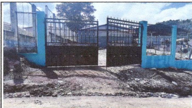
Foto 3: Sustrucción de portón de metal
