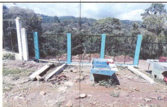
Foto 4: Sustrucción de muro perimetral de block con tubo HG y malla galvanizada, solera de intermedia y columnas
