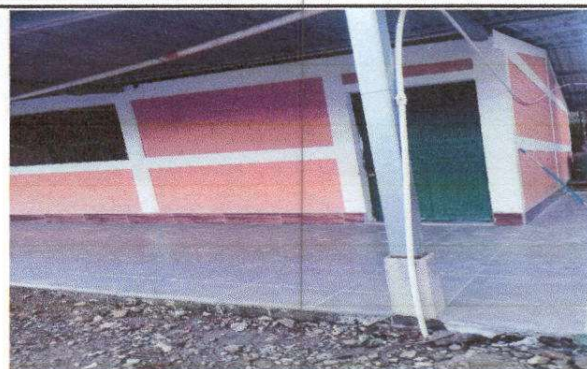
Foto 2: Sustrucción de piso de torta de concreto a piso cerámico área de cocina.
