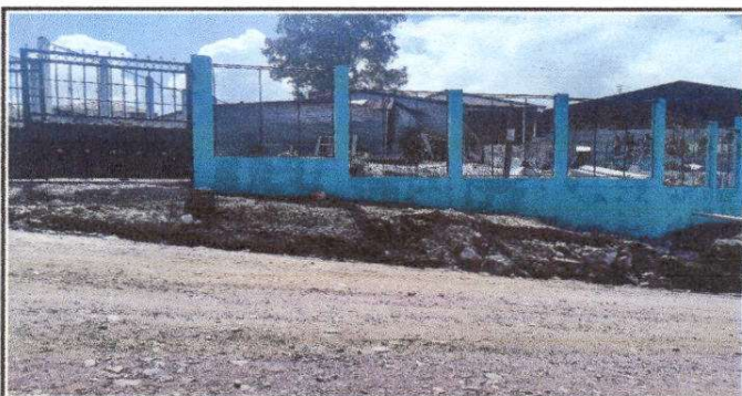
Foto 5: Sustrucción de muro perimetral de block con tubo Hg y malla galvanizada, solera de intermedia y columnas.
